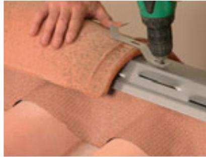
Ils sont principalement chargés d'assurer l'étanchéité des faîtages et arêtiers, mais aussi la ventilation haute des couvertures. Présentés en éléments d'un mètre ou en rouleau, les bords sont munis d'une bande en plomb permettant la mise en forme au profil du matériau de couverture. La partie haute est munie d'ouvertures assurant la fonction ventilation. Des accessoires efficaces et faciles à poser qui envoient au musée la vieille technique du faîtage scellé.
