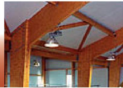
Autres poutres, poutres contrecollées / poutres lamellé-collées / poutres en lame centrale bois.
