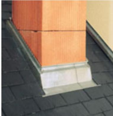
L'abergement doit assurer l'étanchéité entre la couverture et le boisseau du conduit de fumée. Afin de s'adapter aux différents matériaux de couverture ces éléments sont également pourvus d'une bavette plate ou plomb.
