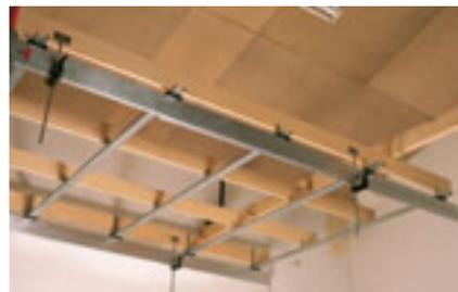
Ces plafonds sont constitués de plaques de plâtre vissées sur une ossature métallique. Quel que soit le support (bois, métal, béton ou hourdis) des accessoires vous permettent d'assurer la fixation des rails constituant l'ossature métallique. La destination du plafond, le sens de pose et les contraintes techniques à prendre en compte déterminent le choix du type d'accessoire à utiliser. Pour ne pas commettre d'erreurs, soumettez votre projet "plafond" au conseiller de vente **Bâtiland**.
